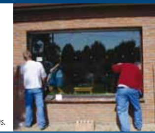
Vervanging van enkel glas door hoogrendementsglas.
